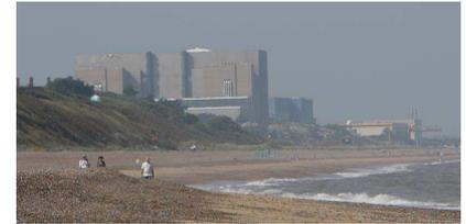
FIGURE 24.9. Centrales de Sizewell. Sizewell A, au premier plan, avait une capacité de 420 MW, et a été arrêtée fin 2006. Sizewell B, derrière, a une capacité de 1,2 GW. Photo de William Connolley.
