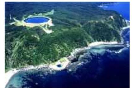
FIGURE 26.11. Centrale de pompage d'Okinawa, dont le réservoir aval est l'océan. Quantité d'énergie stockée : 0,2 GWh. Photo gracieusement fournie par J-Power. [www.ieahydro.org](http://www.ieahydro.org).
