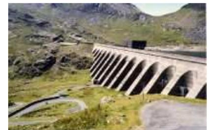
FIGURE 26.6. Llyn Stwlan, le réservoir amont de l'installation de stockage par pompage de Ffestiniog, au nord du Pays de Galles. Énergie stockée : 1,3 GWh. Photo de Adrian Pingstone.
