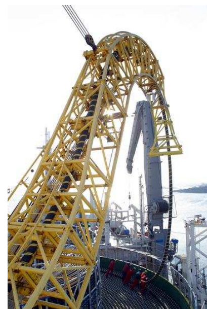
FIGURE 25.7. Pose d'une ligne à haute tension en courant continu entre la Finlande et l'Estonie. Une paire de ces câbles transmet une puissance de 350 MW. Photo : ABB.
