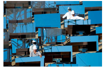
FIGURE 25.12. Deux techniciens en train d'assembler une centrale solaire à concentration eSolar utilisant des héliostats (des miroirs qui tournent et s'orientent pour suivre la course du Soleil). esolar.com fabrique des centrales à taille intermédiaire : une unité de génération de 33 MW (crête) sur un site de 64 hectares. Cela représente 51 W/m 2 en crête. J'en déduis donc que dans un site désertique typique, cette unité fournirait environ un quart de cette valeur : 13 W/m 2 .
