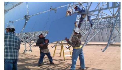
FIGURE 25.4. Andasol — une centrale solaire de « 100 MW » en construction en Espagne. L'énergie thermique en excès produite durant le jour est stockée dans des réservoirs de sels fondus pendant une durée maximum de 7 heures, permettant une fourniture stable et continue de puissance au réseau électrique. La centrale est prévue pour produire 350 GWh par an (40 MW). Les miroirs paraboliques occupent 400 hectares, et leur puissance par unité de surface sera de 10 \text{ W/m}^2 . Photo du haut : ABB. Photo du bas : IEA SolarPACES.
