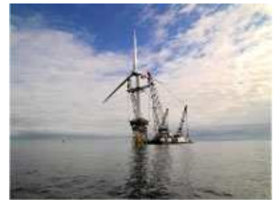
FIGURE 10.8. Construction du parc expérimental d'éoliennes en mer profonde Beatrice. Photos aimablement fournies par Talisman Energy (UK) Limited.
