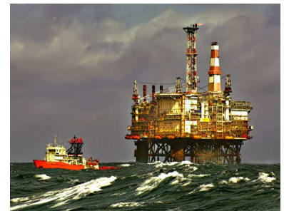
FIGURE 10.4. La plate-forme Magnus dans le secteur britannique nord de la mer du Nord, contient 71 000 tonnes d'acier. En l'an 2000, cette plate-forme a fourni 3,8 millions de tonnes de pétrole et de gaz — soit une puissance de 5 GW. La plate-forme a coûté 1,1 milliards de livres sterling (1,3 milliards d'euros). Photos par Terry Cavern.
