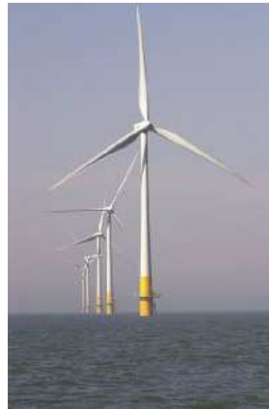
FIGURE 10.1. Kentish Flats — un parc éolien en mer peu profonde. Chaque rotor a un diamètre de 90 mètres dont l'axe est situé à 70 mètres de haut. Chacune des turbines de « 3 MW » pèse 500 tonnes, dont la moitié pour ses fondations.
